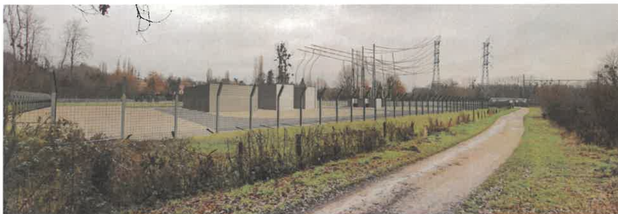
Photomontage d'insertion du poste source dans son environnement sur la commune de Cinqueux (Source : pièce 1D Annexe commune aux trois permis de construire page 37)
